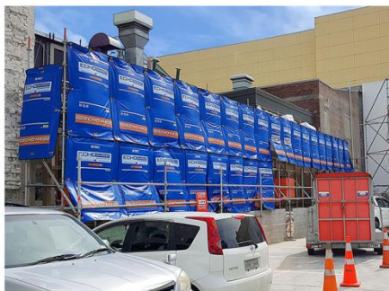
Construction Site 建筑工地
